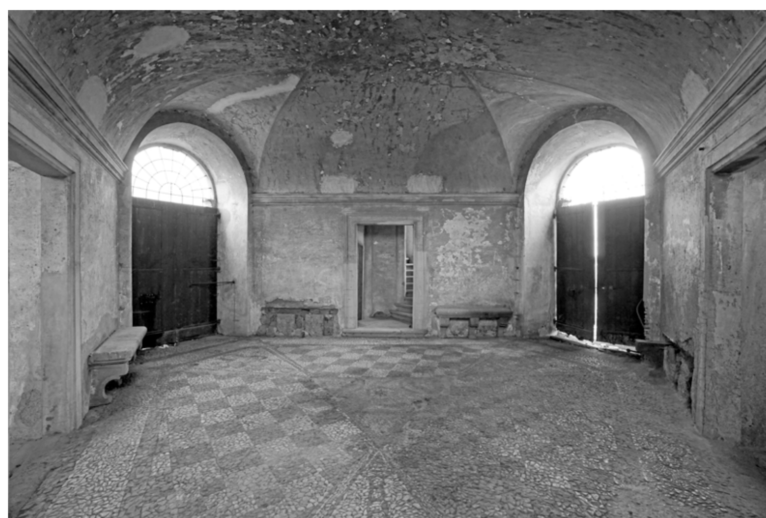
Zentraler Raum im Erdgeschoss
