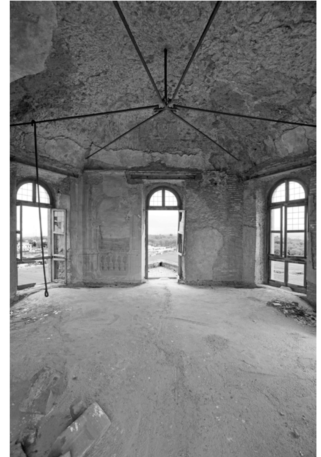
Zentraler Raum im 2. Obergeschoss
