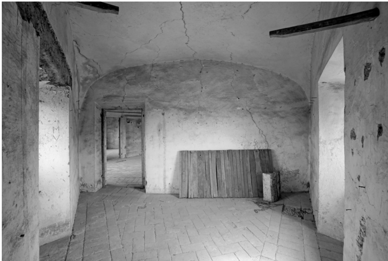
Dreieckiger Raum im Mezzaningeschoss
