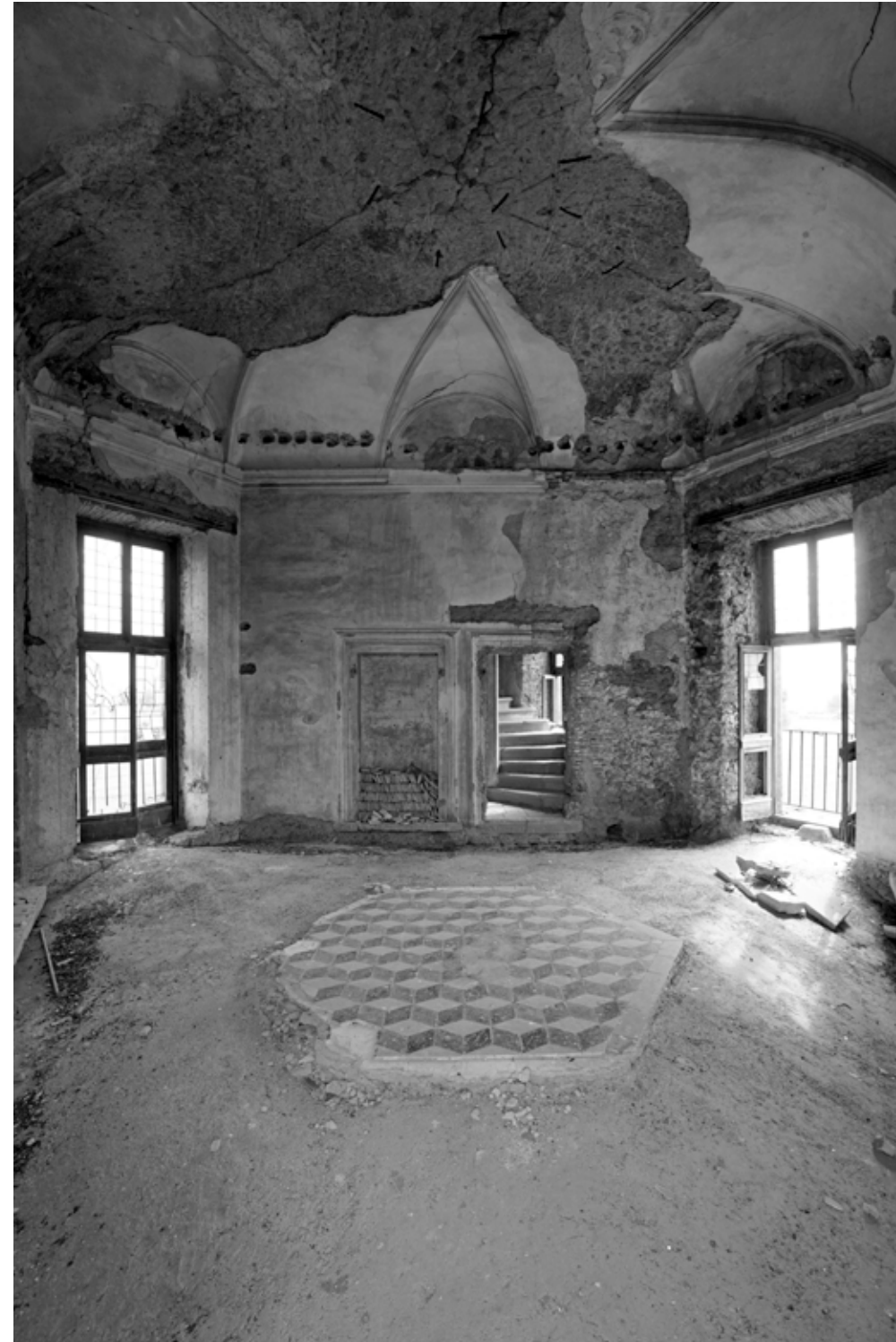
Zentraler Raum im 1. Obergeschoss
